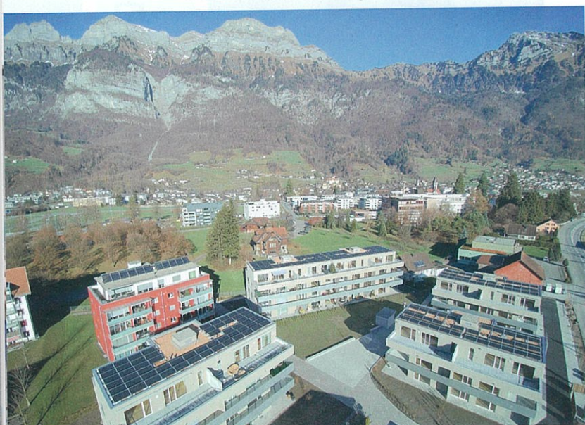
In Walenstadt ist seit Januar 2019 der erste lokale Strommarkt der Schweiz in Betrieb aufgenommen. (Bilder: WEW, Wasser- und Elektrizitätswerk Walenstadt)
